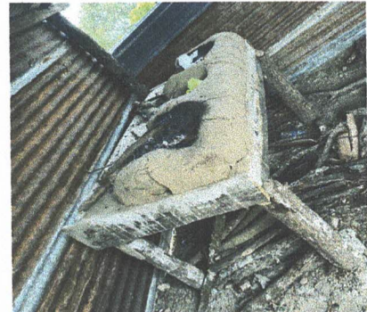
Foto 22: Sustrucción de estufa rural (Completa) Incluye polletón, chimenea y plancha de metal
