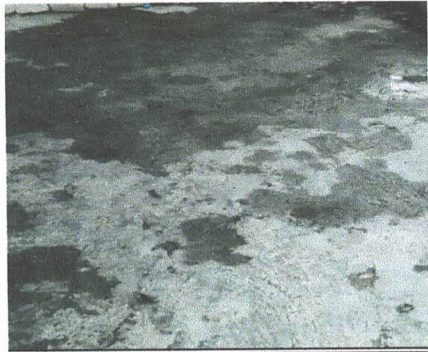
Foto 19: Sustrucción de piso de torta de concreto
