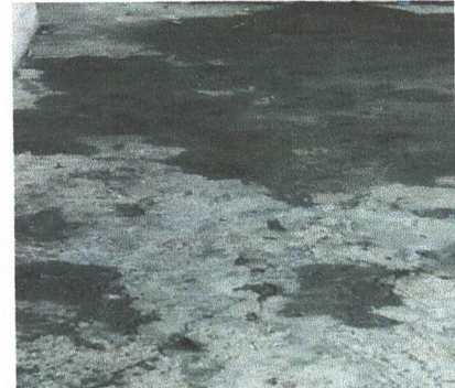
Foto 20: Sustrucción de piso de torta de concreto
