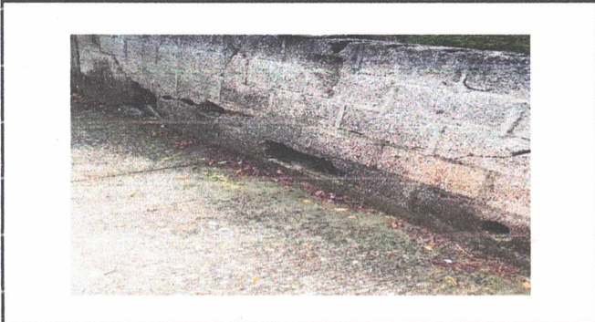
SUSTITUCIÓN DE MURO PERIMETRAL
