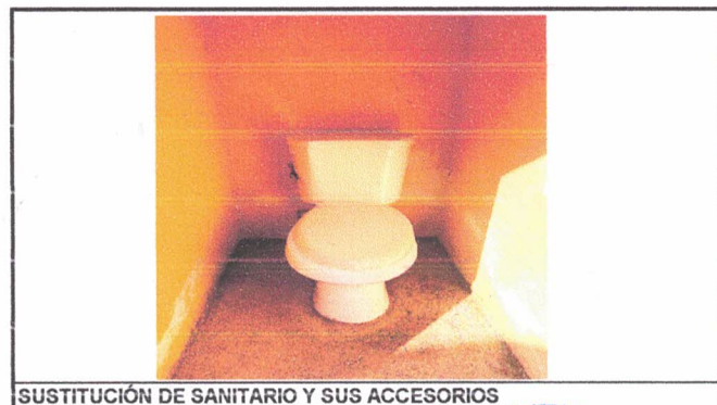
SUSTITUCIÓN DE SANITARIO Y SUS ACCESORIOS
