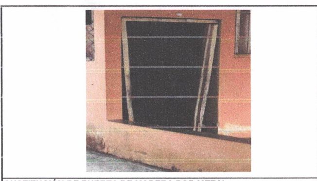
SUSTITUCIÓN DE PUERTA DE MADERA POR METAL
