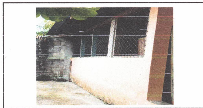
SUSTITUCIÓN DE VENTANAS DE MALLA POR VENTANAS CORREDIZAS DE PVC
