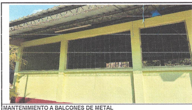
MANTENIMIENTO A BALCONES DE METAL
