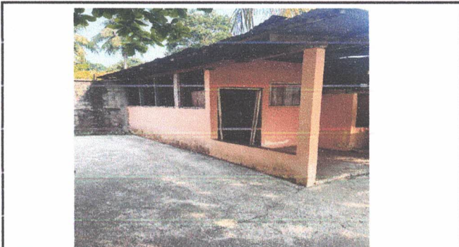
SUSTITUCIÓN DE PLANCHAS DE CONCRETO DE PATIO COMPLETO
