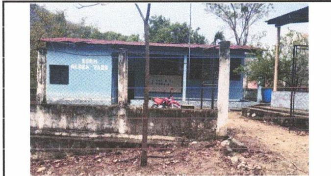
Foto 1: Reparación de Muro Perimetral con Malla Galvanizada Rombo de 1 1/2" Calibre 12 y Reparación de Portón Metalico.
