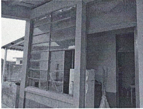
Foto 1: ventana de despacho de alimentos que será remozada con PVC y balcón nuevo.
