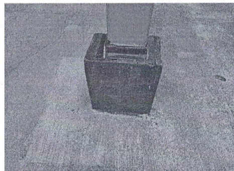
Foto 6: columnas a edificar para soportar el peso de la galera que se ampliará
