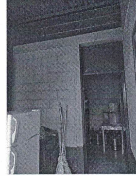
Foto 2: muro a demoler para ampliación de cocina
