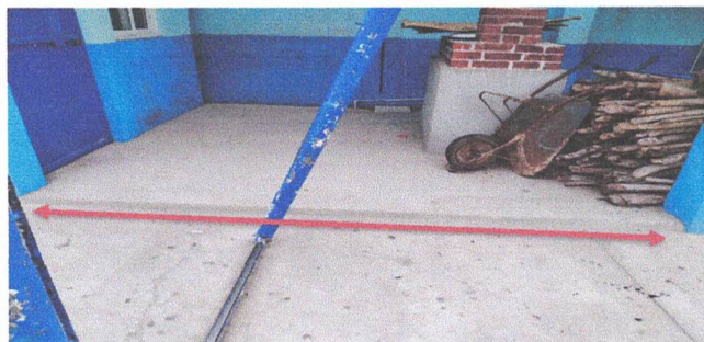
Colocación de rejilla e instalación de drenaje para agua pluvial
