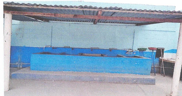
Demolición de Pila y Construcción de una de 2 m x1m
