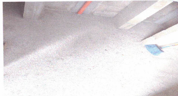
Sustitución de Piso de Granito Por Ceramico
