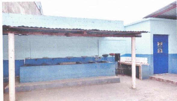
Cambio de Techo por lámina troquelada y estructura de metal
