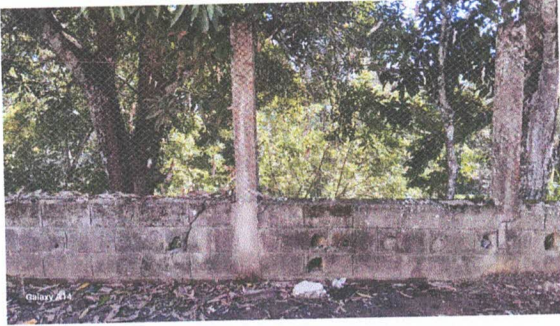
Foto 1: 1.1 Repello de muro perimetral 100ML
