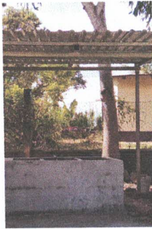
Foto 5: 2.1 Reparación de piso de torta de concreto de pila 3x3.50; 10.50 M2
