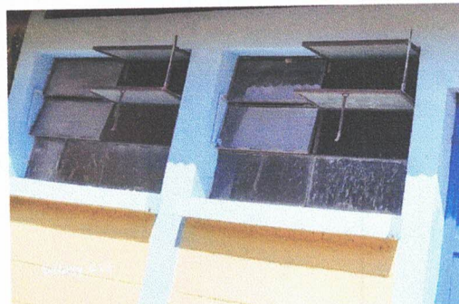
Foto 2: 3.2 Sustitución de ventana de metal por ventanas de PVC de dos unidades de 1.5x 1; 3 M2c/u
