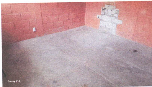
Foto1: 3.1 Sustitución de torta de concreto por cerámico 4x4.25; 17 M2
