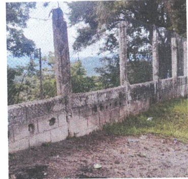
Foto 4: 1.4 Pintura de muro perimetral 100ML
