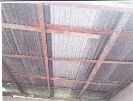
Foto 5: 3.5 Sustitución de lámina ondulada por lámina troquelada aluzinc calibre 26, 6x6; 36 M2
