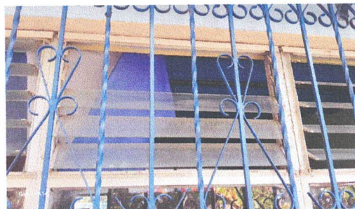
Foto 6: 4.1 Sustitución de ventana de metal por ventana PVC de dos unidades de 3.75 x0.80; 6 M2
