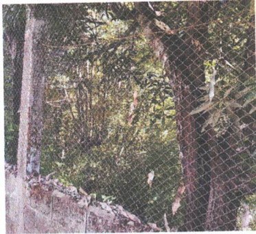
Foto 3: 1.3 Sustitución de maya por deterioro a balcones de maya de 2.20 x 1.50; 3.30 M2 c/u.
