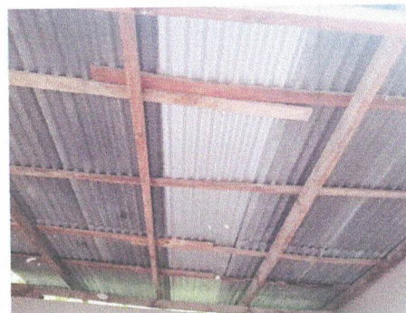
Foto 4: 3.4 Sustitución de estructura de soporte de madera por metal 6x6; 36ML.
