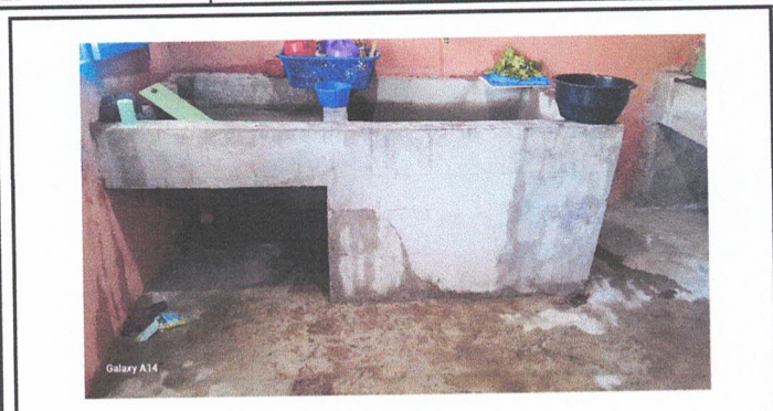
Foto 1: Instalación de azulejo a pila de concreto de cocina 8M2
