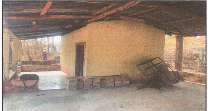
Foto 4: REPARACION DE LAMINA Y ESTRUCTURA
