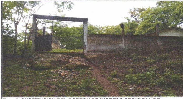
Foto 5: SUSTITUCION DEL PORTON DE INGRESO PRINCIPAL DE ESCUELA ✓
