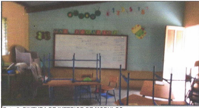
Foto 5: PINTURA DE INTERIOR DE MODULOS
