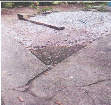
Foto 5: sustitución de torta de concreto de cemento.
