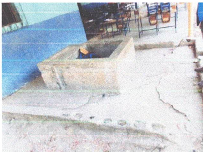
REPARACIÓN DE COCINA
