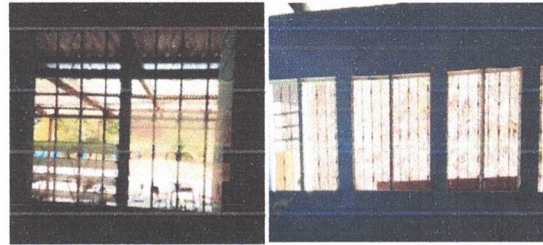
SUSTITUCION DE BALCONES Y DE ESTRUCTURA DE METAL EN VENTANAS
