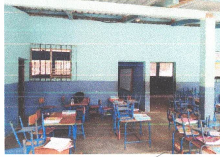
PINTURA EN MUROS INTERIORES Y EXTERIORES
