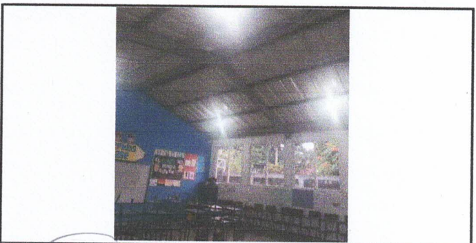
Foto 4: (Reparación de Cielo Razo de PVC, Lámparas Led En SALON No.1, SALON No.2, DIRECCION Y BODEGA O PERNOCANCIA.
