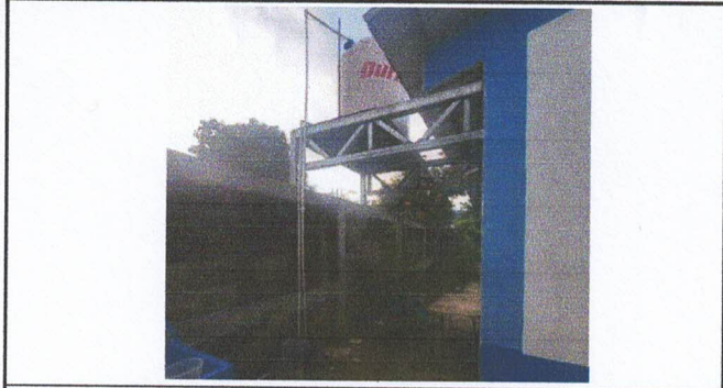
Foto 1: Reparación de Torre (Refuerzo) y Deposito de Agua Potable para 2,500 LITROS.
