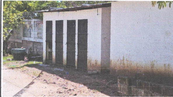
Foto 2: Pintura en muros exteriores e interiores
