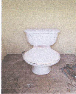
Foto1: Sustitución de inodoros
