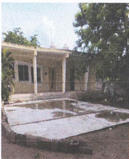
Foto 5: Reparación de piso de torta de concreto
