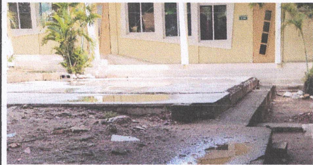
Foto 4: Reparación de piso de torta de concreto
