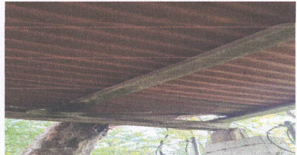
Foto 2: Sustitución o instalación de lámina por lámina troquelada aluzinc calibre 26 /
