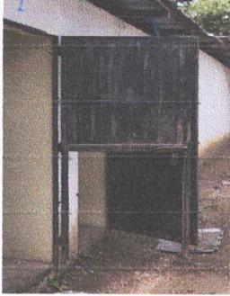
Foto 1: Sustrucción de puerta de metal
