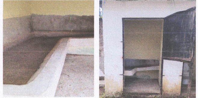
Foto 2: Sustitución de migitorio
