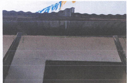
Foto 4: Reparación de techo en módulo de baños
