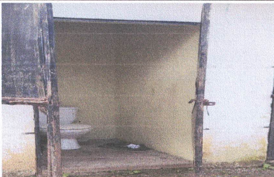
Foto 5: Sustitución de inodoros /
