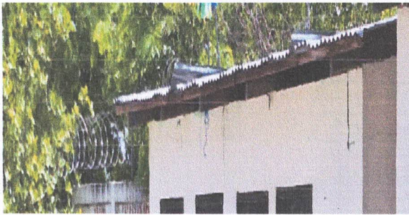
Foto 3: Reparación de techo en módulo de baños
