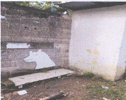
Foto 5: Sustitución de lavamanos
