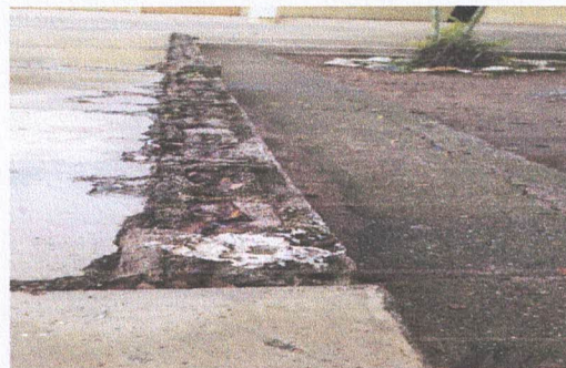
Foto 6: Cajuela de block para piso de concreto /
