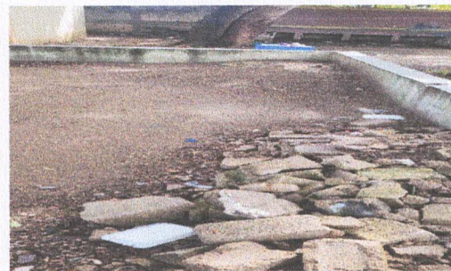
Foto 4: Cajuela de block para piso de concreto /
