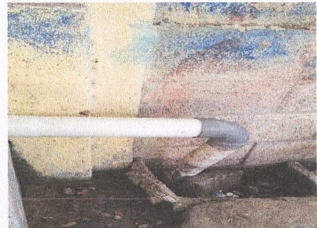
Foto 6: Reparación de tubería de drenaje
