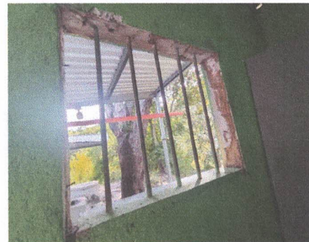
INSTALACIÓN DE VENTANA DE METAL
