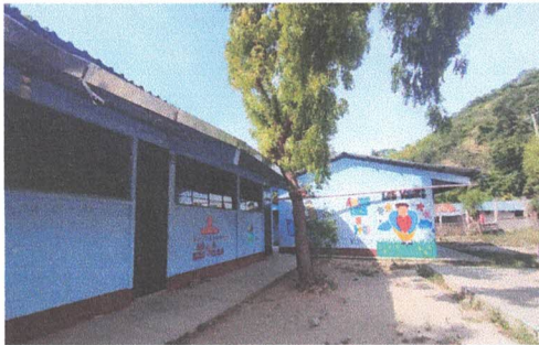
APLICACIÓN DE PINTURA EN MUROS EXTERIORES
