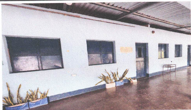
Foto 3: SUSTITUCIÓN DE BALCONES DE METAL EN AULAS.
