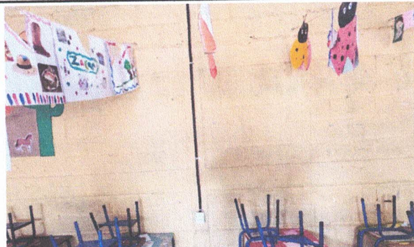
Foto 4: DEMOLICIÓN DE AREA PARA INSTALAR BALCONES DE METAL EN AULA.
