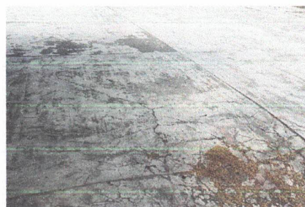
Foto 6: Sustitución de piso de torta de concreto
