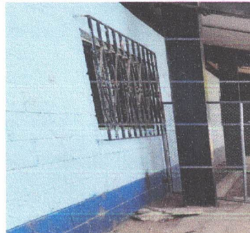
Foto 4: Sustitución de balcones de metal
