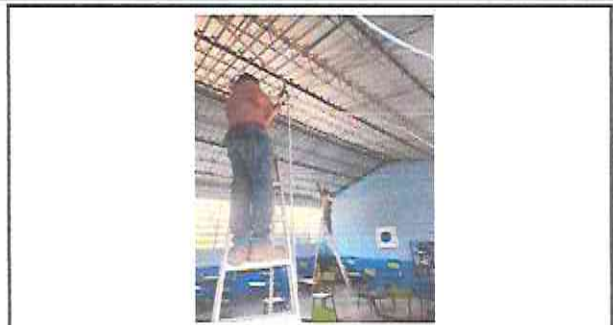
Foto 2: lamparas dañadas y sistema deficiente
