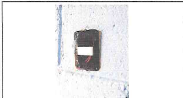
Foto 1: interruptores dañados que necesitan cambio
