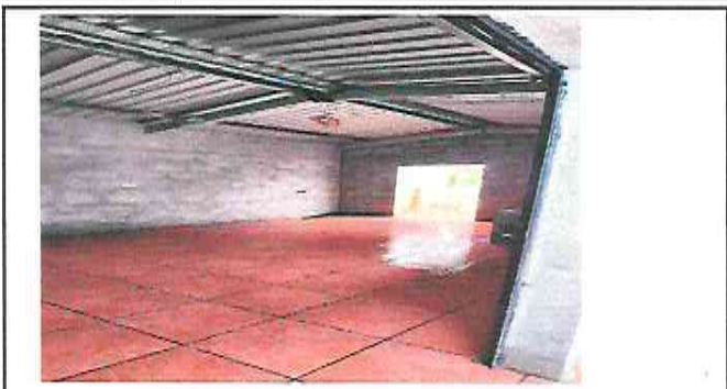
Foto 2: Sustitución de lámina
