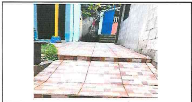
Foto 3: Sustitución de piso cerámico
