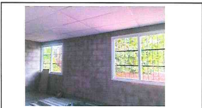
Foto 4: Sustitución de ventanas PVC y sustitución de estructura de metal de ventana
