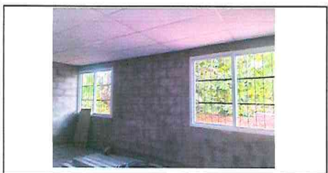
Foto 5: Reparación de repello y cernido de paredes
