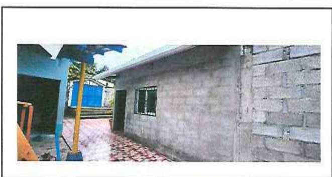
Foto 6: Sustitución de puerta de metal, sustitución de canales y bajadas de agua pluvial
