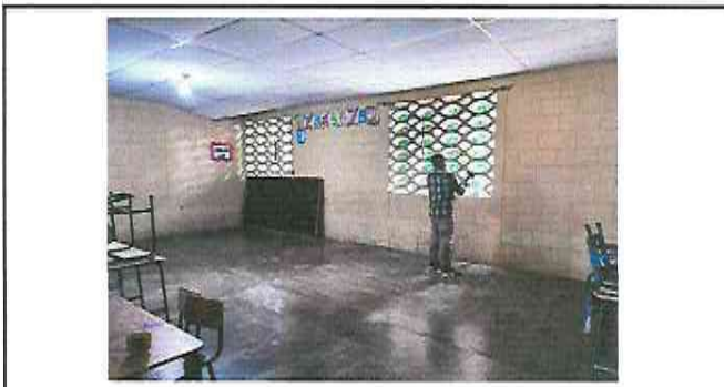
Foto 4: Sustitucion de ventanas PVC y sustitucion de estructura de metal de ventana
