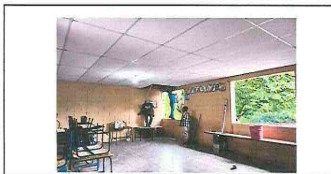
Foto 5: Reparacion de repello y cernido de paredes
