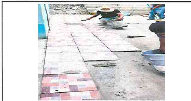
Foto 3: Sustitucion de piso ceramico
