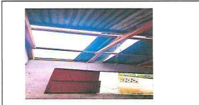
Foto1: Sustitución de estructura de madera por estructura metalica, sustitucion de sistema electrico
