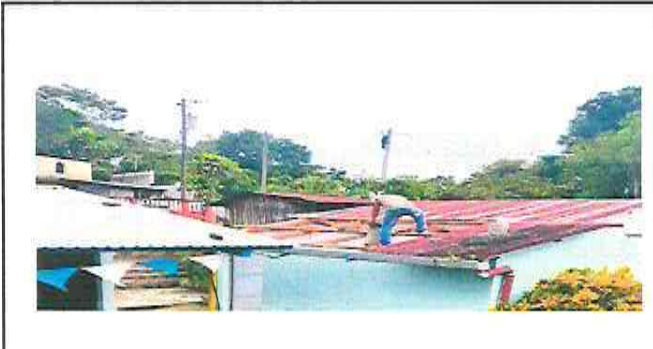
Foto 2: Sustitucion de lamina
