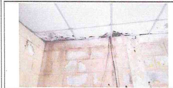
REPARACIÓN DE REPELLO Y CERNIDO DE PAREDES ✓
