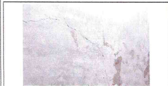
SUSTITUCIÓN DE PISO POR PISO CERAMICO ✓
