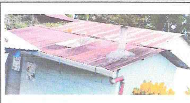
SUSTITUCIÓN DE LÁMINA
