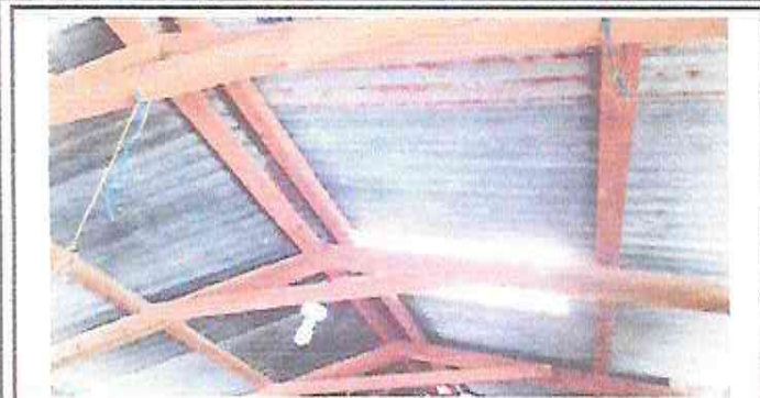
SUSTITUCIÓN DE ESTRUCTURA DE MADERA POR ESTRUCTURA METÁLICA, SUSTITUCIÓN DEL SISTEMA ELÉCTRICO y lamina!
