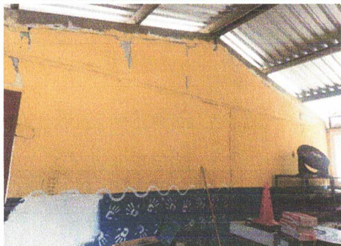
Foto7: Tratamiento de paredes de dirección, interiores
