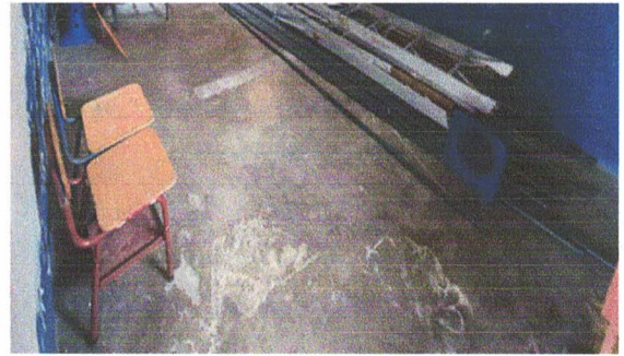
Foto 2: Sustitución de piso liso por piso cerámico en interior de dirección.
