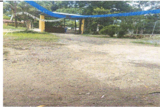
Foto 6: Losa de patio de entrada principal.
