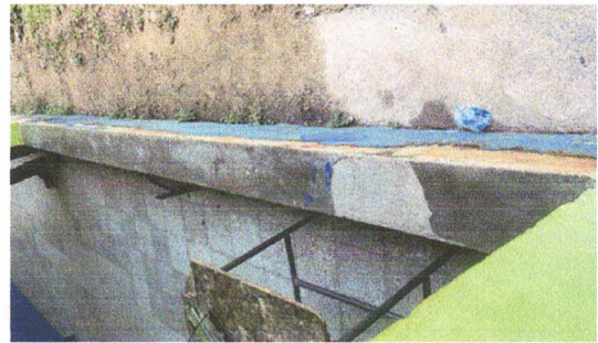
Foto 4: Sustitución de pretil de corredor de aulas .
