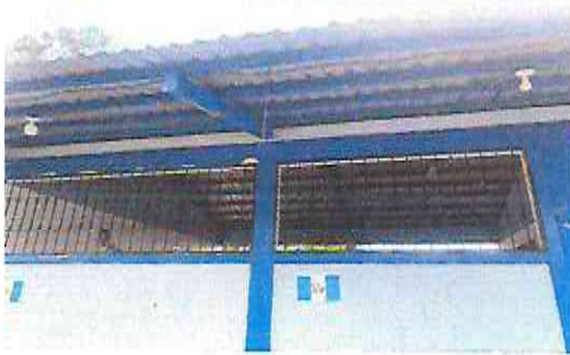
Foto 5: Sustitución de balcones de metal
