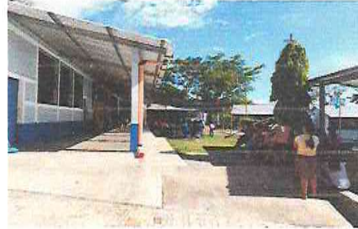
Foto 2: Sustitución de lámina por lámina troquelada aluzinc calibre 26
