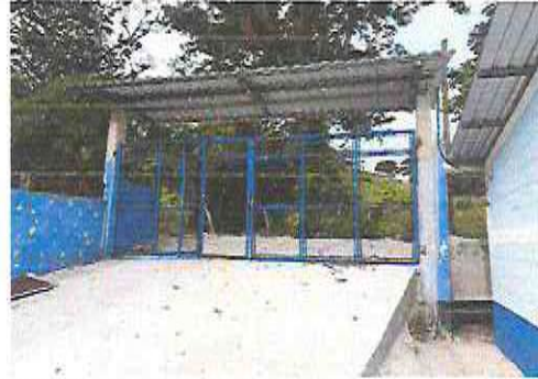
Foto 2: Sustitución de piso de torta de concreto por piso de igual consistencia
