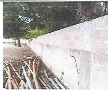
Foto 4: Sustitución de muro perimetral de concreto
