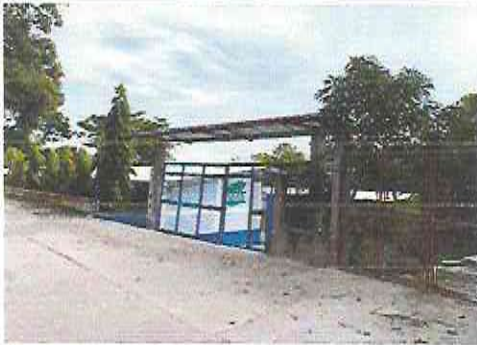
Foto 3: Suministro e intalación de galera a portón
