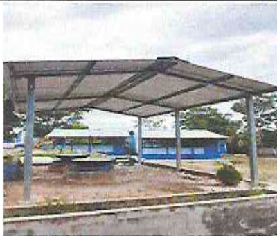
Foto 5: Sustitución de lámina por lámina troquelada aluzinc calibre 26
