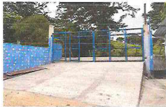
Foto 4: Sustitución de piso de torta de concreto por piso de igual consistencia
