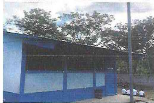
Foto 6: Sustitución de balcones de metal
