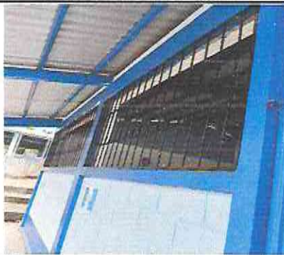
Foto 3: Sustitución de balcones de metal
