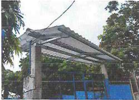
Foto 1: Suministro e intalación de galera a portón
