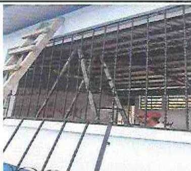
Foto 5: Sustitución de balcones de metal
