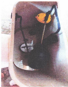
Foto 3: Sustitución de accesorios de sanitario
