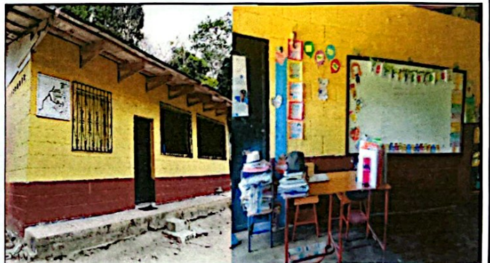
Foto 4: 1.4 PINTURA EN MUROS INTERIORES Y EXTERIORES
