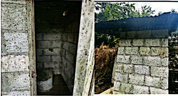
Foto 9: PINTURA EN MUROS INTERIORES Y EXTERIORES
