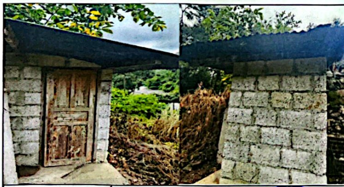
Foto 5: 2.1 SUSTITUCIÓN DE PAREDES DE CONCRETOS
