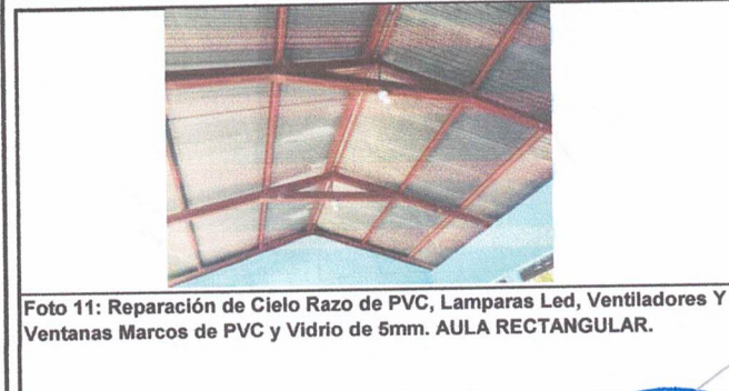
Foto 9: Reparación de Cielo Razo de PVC, Lamparas Led, Ventiladores Y Ventanas Marcos de PVC y Vidrio de 5mm. AULA RECTANGULAR.
