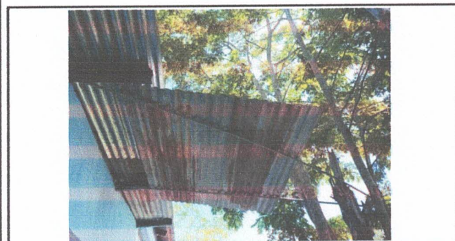
Foto 3: Reparación de Cocina, Polletones, Sustitución de Estructura y Techo de Lamina Troquelada C26 LEGITIMO.
