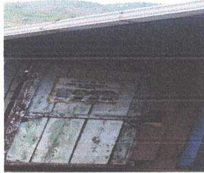
Foto1: Mantenimiento a bodega (Sustitución de puerta de madera por metal, repello y cernido en paredes y sustitución de canal plástico por canal de metal)
