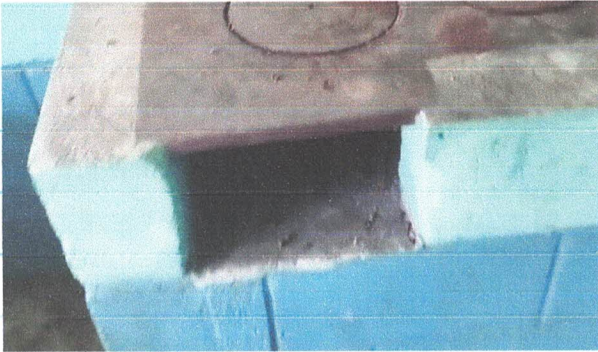
Sustitución de estufa rural completa (incluye polletón, cambio de plancha de metal y chimenea)
