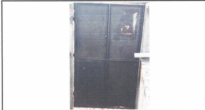
Sustitución de puertas de metal de los baños
