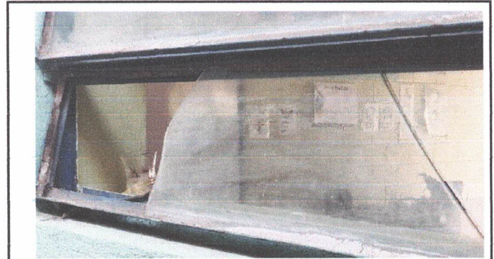
Mantenimiento a estructura de metal de ventanas
