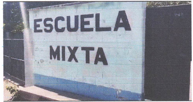
Pintura en muros interiores y exteriores
