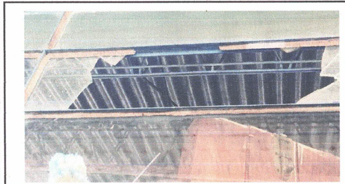
Sustitución de vidrios de ventanas (incluye estructura de soporte de metal, instalación y flete)
