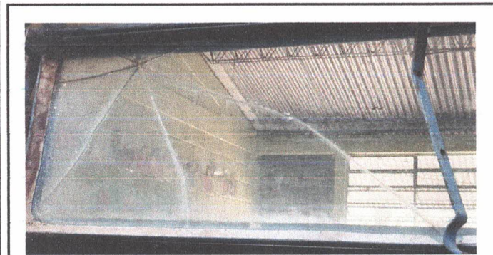
Sustitución de vidrios de ventanas (Incluye estructura de soporte de metal, instalación y flete)
