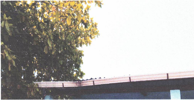
Sustitución de canales de bajada de agua pluvial de metal
