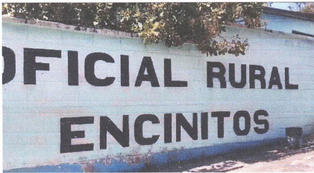
Pintura en muros interiores y exteriores
