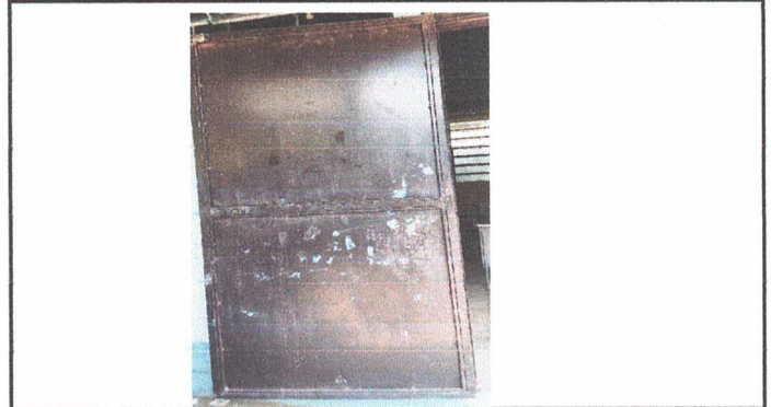
Sustitución de puertas de metal de las aulas
