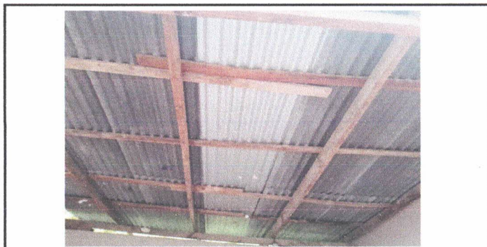
Foto 5: Desmonado de techo de pila, sustitución de lamina ondula por lamina troquelada aluzinc calibre 26 y estructura de soporte de madera por metal en techo de pila
