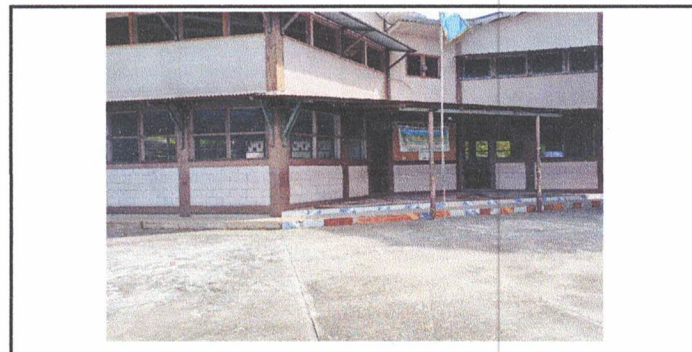
Foto 6: Pintura de exteriores de aulas (2 aulas), 200 M2
