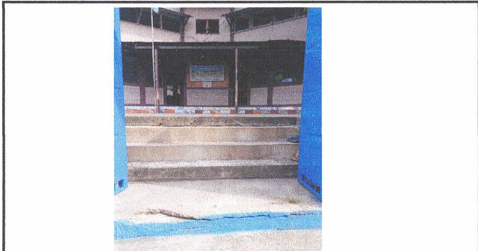
Foto1: Reparación de 4 gradas y reparación de porton principal NO SE OBSERVA EN FOTOGRAFIA
