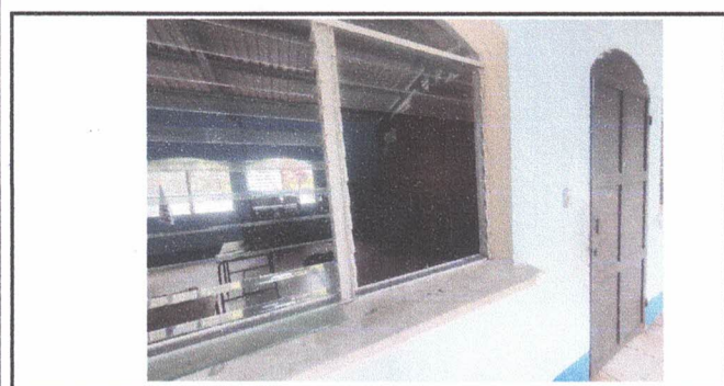
Foto 5: Sustitución de estructura de metal de ventanas
