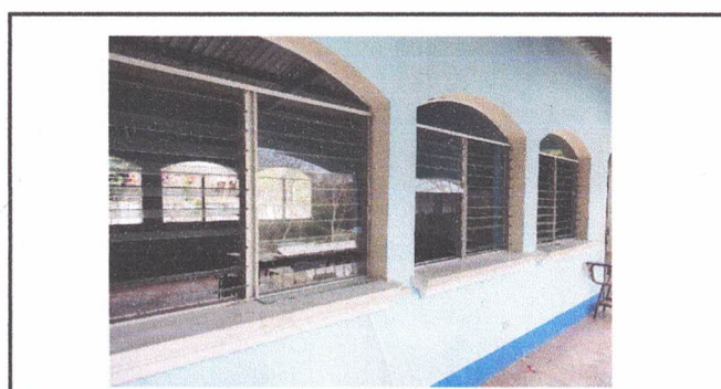
Foto 6: Sustitución de estructura de metal de ventanas y cambio de vidrios
