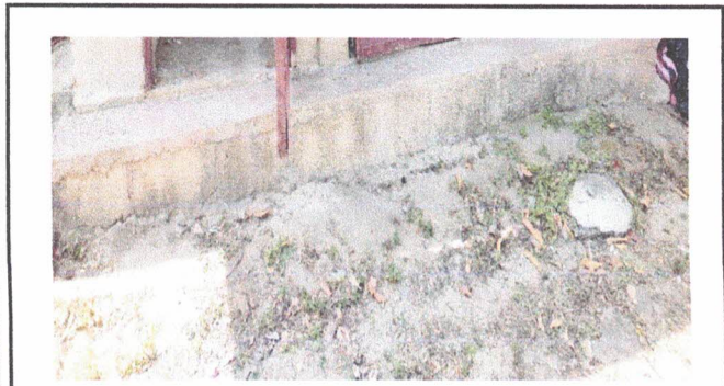
Foto 3: Sustitución completa de piso de torta de concreto
