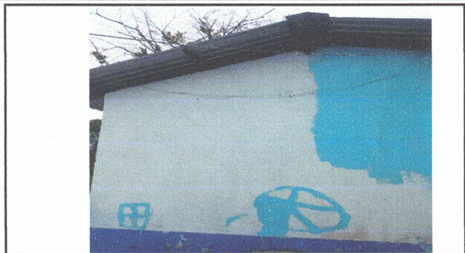
Foto 7: Pintura en muros (paredes) interiores y exteriores
