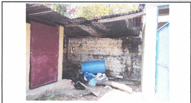
Foto 1: Sustitución de estructura de soporte de madera por metal y sustitución de lámina por lámina troquelada aluzinc calibre 26
