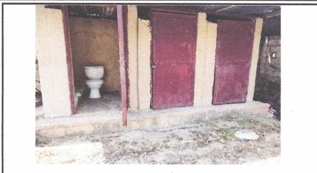
Foto 2: Sustitución de estructura de metal (puertas de los baños)
