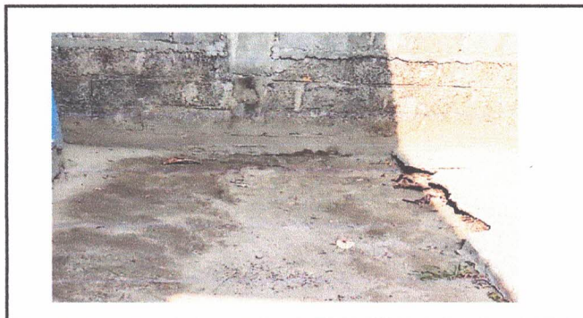
Foto 10: Reparación de planchas de concreto de patio
