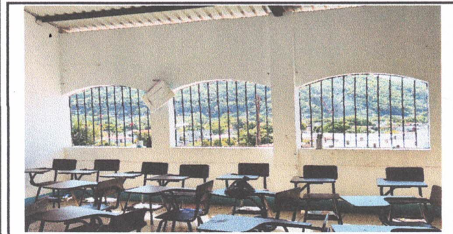
Foto 5: Instalación de ventanas de PVC en las dos aulas del segundo nivel, que no tienen ventanas y con la lluvia se moja adentro del salón de clase. Aula 1.
