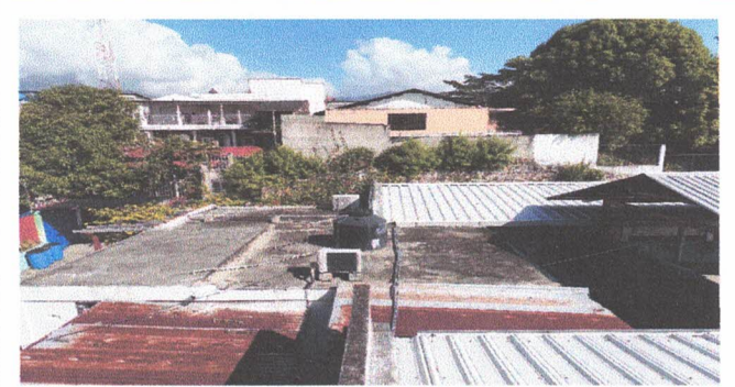
Foto 3: Toda el area de dirección que se aplicará mezción y se harán desniveles para evitar que se filte el agua.
