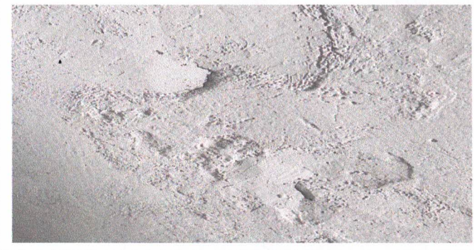
Foto 5: Daños en repello de terreza por el problema de la filtración.
