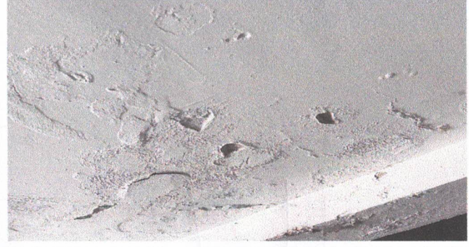
Foto 6: Filtración de humedad por daños en la terreza.
