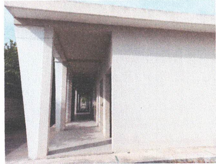
Foto 2: Pintura interior y exterior de aulas.
