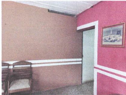
Foto 5: Elaboración y colocación de puerta en sala de maestros.
