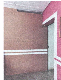
Foto 6: Elaboración y colocación de puerta en sala de maestros.
