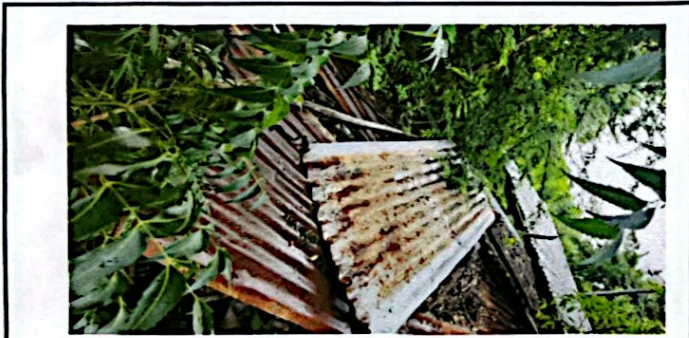
Foto 3 Modulo C Galera, necesita ser sustituida ya que el agua daño la lamina.
