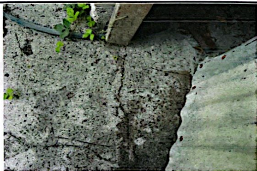
Foto 7: Sustitución de piso de torta de concreto
