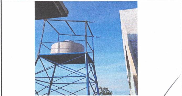
Mantenimiento a estructura de deposito de agua (Lijado, cepillado y pintado) y sustitución e instalación de cisterna de 1700 lts.
