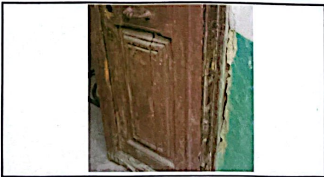
Foto 6: Sustrución e instalación de puerta de PVC
