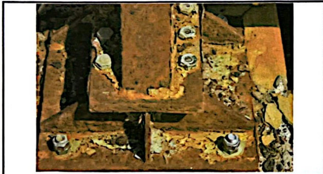
Foto 3: Sustrución e instalación de estructura de metal Galbanizado
