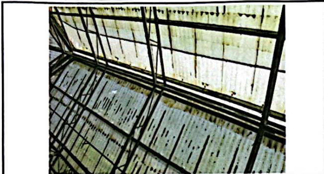
Foto 1: Sustrución e instalación de lamina por lamina troquelada metalica calibre 26 legitima
