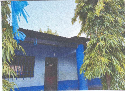
Foto 2: PINTURA EN MUROS EXTERIORES
