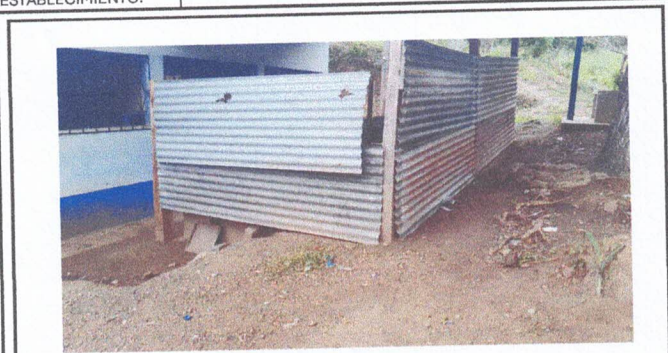
Foto 1: Renglon 1. Cambio por cerramiento con malla galvanizada
