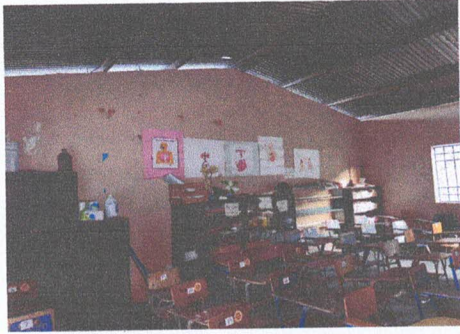
Foto1: PINTURA EN MUROS INTERIORES
