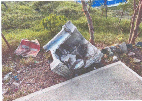
Foto 3: SUSTITUCION DE PILA
