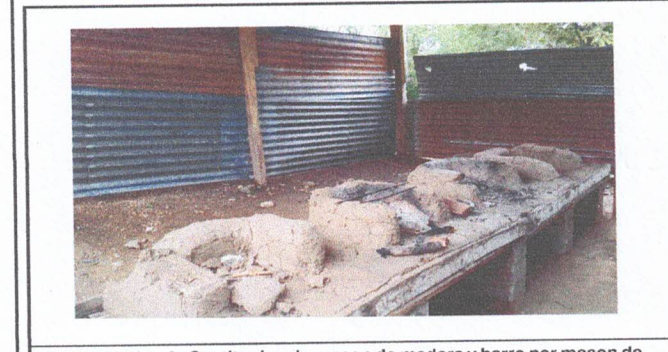
Foto 5: Renglon 6 . Sustitucion de meson de madera y barro por meson de concreto y hornillas de ladrillo
