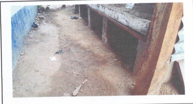
Foto 2: renglon 2. Fundicion de torta de concreto
