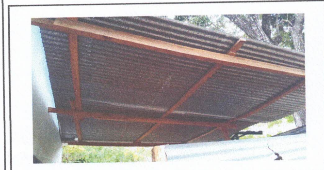
Foto 3: Renglon 3. Cambio estructura de madera por estrcutra metalica
