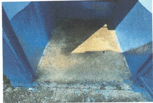
Foto 8: Sustitución de piso de torta de concreto por piso cerámico antideslizante
