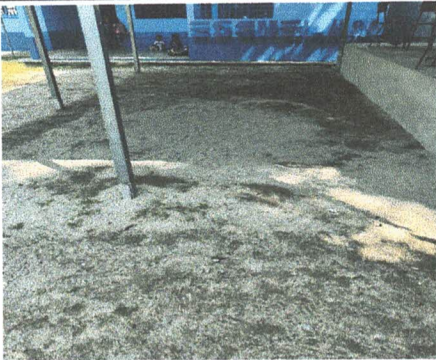
Foto 9: Sustitución de piso de torta de concreto
