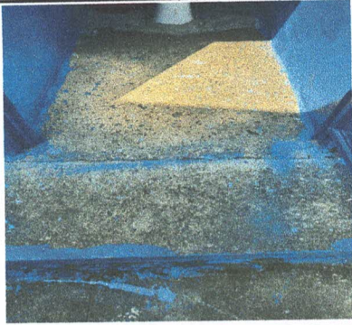
Foto 7: Sustitución de piso de torta de concreto por piso cerámico antideslizante
