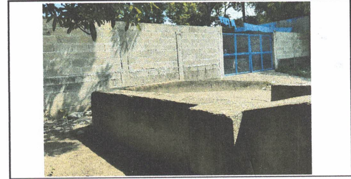
Foto 6: Instalación de azulejo en el área de la pila
