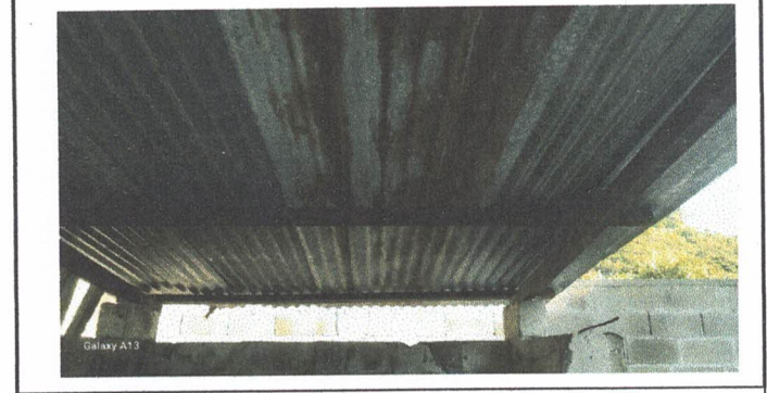
Foto 4: Sustitución de lámina por lámina troquelada calibre 26
