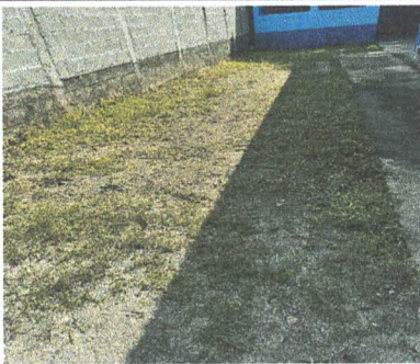
Foto 11: Sustitución de piso de torta de concreto
