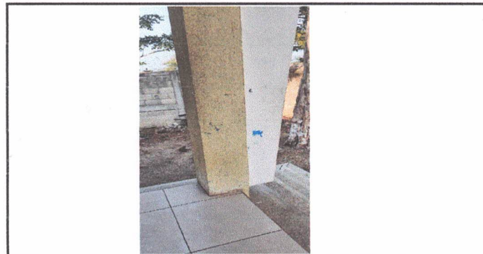
Pintura en muros exteriores e interiores
