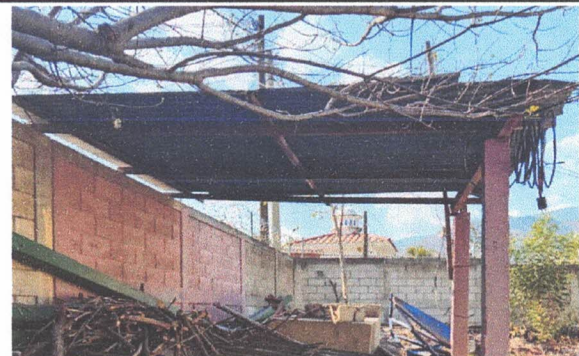
Sustitución de Lámina por Lámina troquelada Calibre 26
