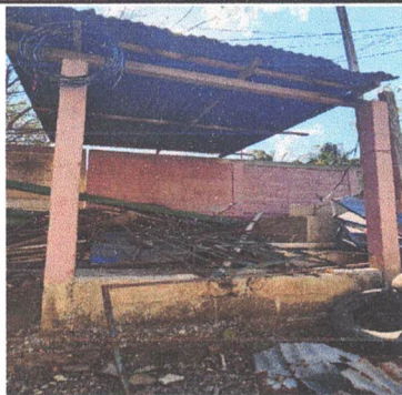
Sustitución de estructura de soporte de madera por metal
