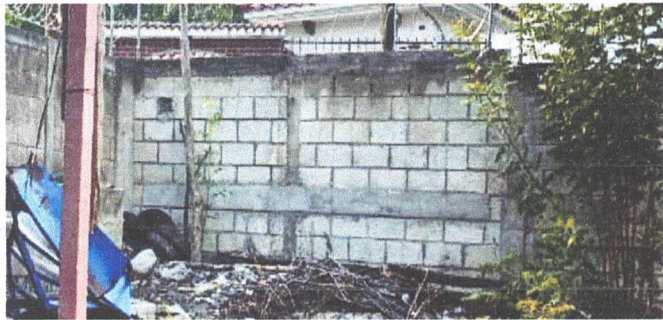
Reparación de muro perimetral
