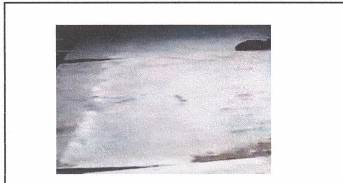
Reparación de piso de torta de concreto
