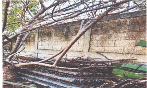
Reparación de muro perimetral
