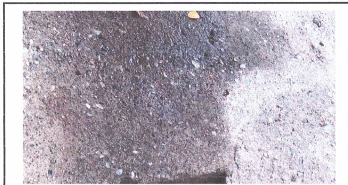
Reparación de piso de torta de concreto
