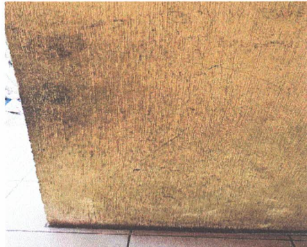
Pintura de muros interiores y exteriores
