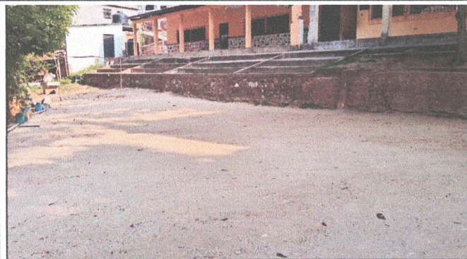
Foto 1: Mejoramiento en patio
