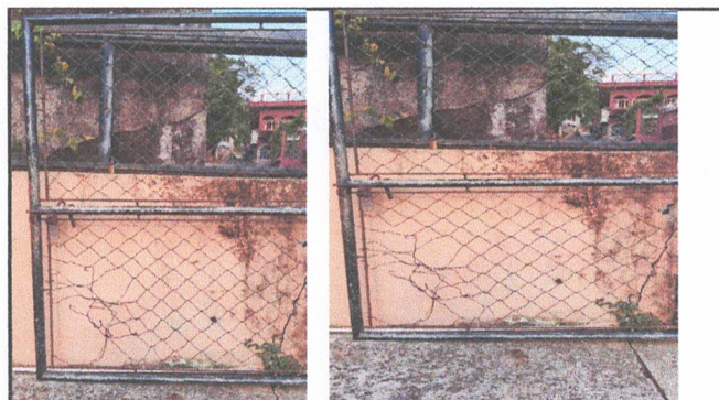
Foto 4: Instalar portón principal.
