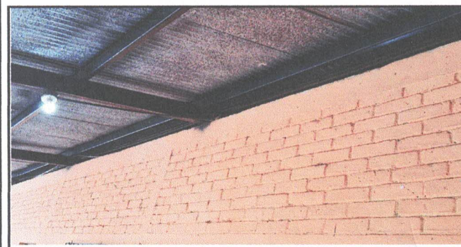
Foto 5: Instalar estructura con maya entre espacio de techo y pared Modulo 3.
