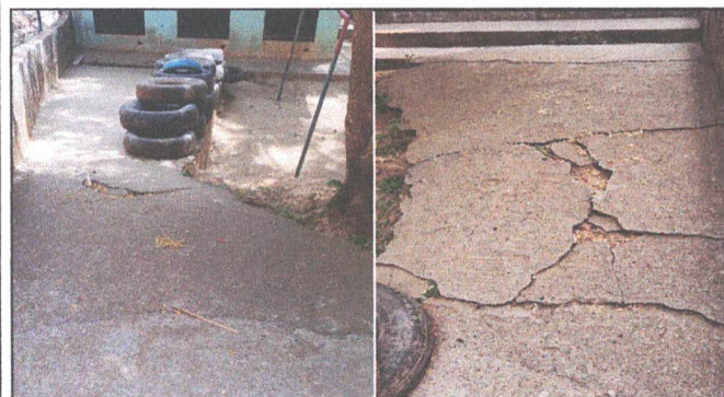
Foto 3: Reparación de rampa de acceso al patio.
