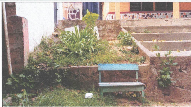
Foto 2: Mejoramiento de gradas de acceso al patio
