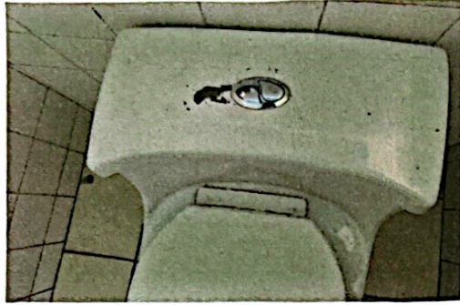
Foto 7 Sustitución de accesorios de inodoro
