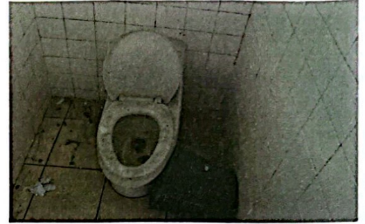
Foto 8 Sustitución de accesorios de inodoro
