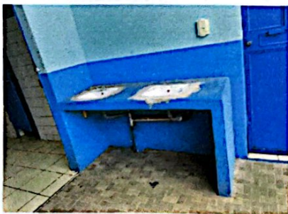
Foto 5: Sustitución de grifos en lavamanos
