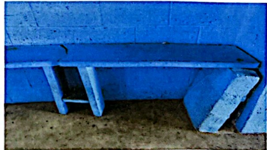
Foto 6: Sustitución de banquetas de madera por concreto.
