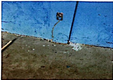
Foto 3: Reparación del sistema eléctrico
