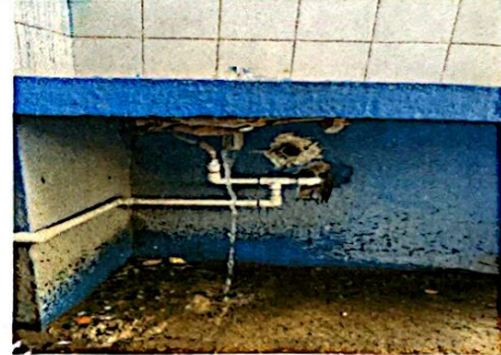
Foto 4: Reparación de tubería en lavamanos
