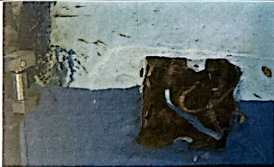
Foto 11: Instalación de unidades de fuerza (tomacorrientes)
