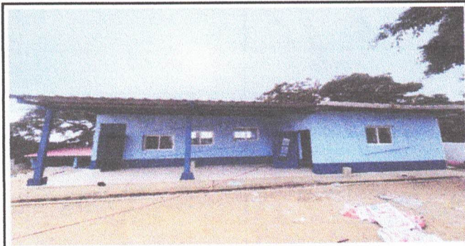
Foto1: 1.1. Instalación canal metal. 1.2. Instalación de bajadas de agua pluvial 4.5 ml c/u).
