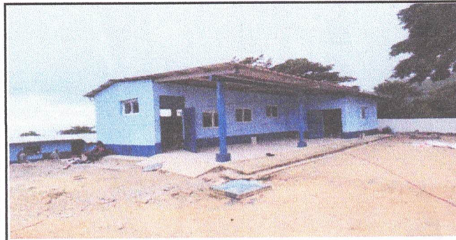
Foto 3: 2.1. Instalación de pretil de block (3 hiladas). 2.2. Instalación de piso de concreto (2.00 m x 27.8 m, frente al aula del modulo 1).
