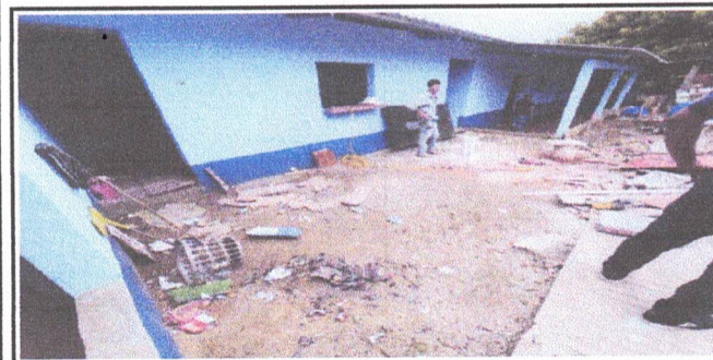
Foto 5: 2.3. Instalación de plancha de concreto
