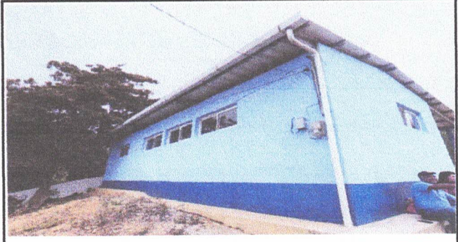
Foto 2: 1.3. Mantenimiento de canal
