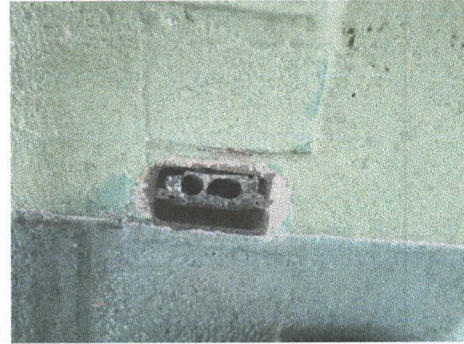
Foto 28: Sustrucción de tomacorrientes dobles
