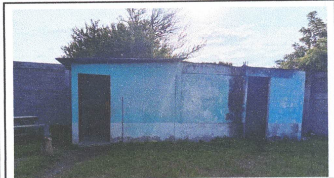
Foto 13: Sustitución de lámina por lámina troquelada aluzinc calibre 26
