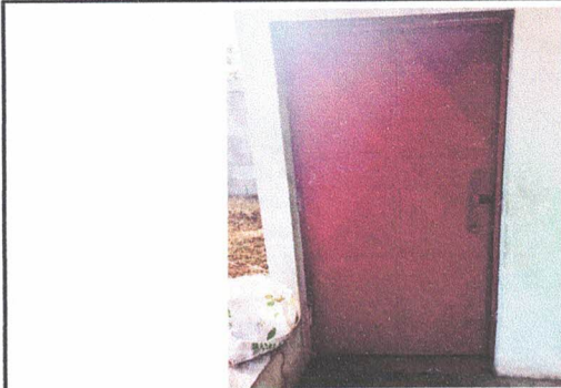
Foto 9: Mantenimiento a estructura de metal de puertas (Lijado, cambio de tubo, cepillado, sujeciones, aplicación de pintura)
