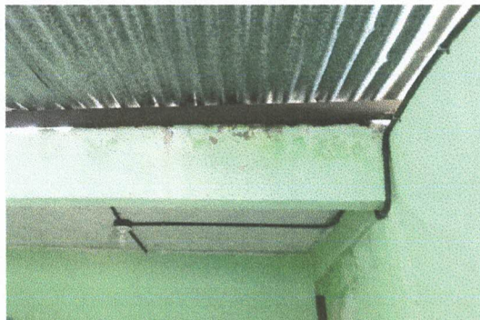
Foto 33: Sustrucción de ducto eléctrico más accesorios
