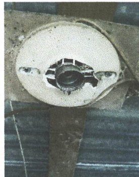
Foto 34: Sustrucción de plafoneras
