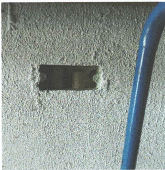
Foto 29: Sustrucción de tomacorrientes dobles
