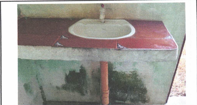
Foto 19: Sustitución de lavamanos
