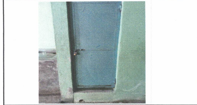
Foto 16: Mantenimiento a estructura de metal de puertas entrada sanitarios (Lijado, cambio de tubo, cepillado, sujeciones, aplicación de pintura)
