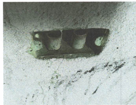
Foto 30: Sustrucción de tomacorrientes dobles
