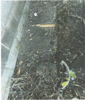
Foto 27: Reparación de banquetas de concreto
