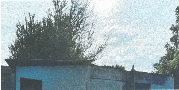
Foto 25: Sustrucción de estructura de metal
