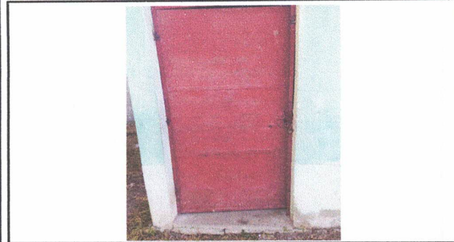
Foto 15: Mantenimiento a estructura de metal de puertas entrada de baños (Lijado, cambio de tubo, cepillado, sujeciones, aplicación de pintura)
