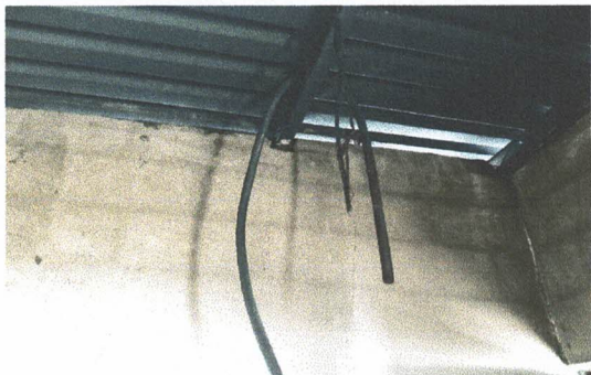
Foto 31: Sustrucción de ducto eléctrico más accesorios
