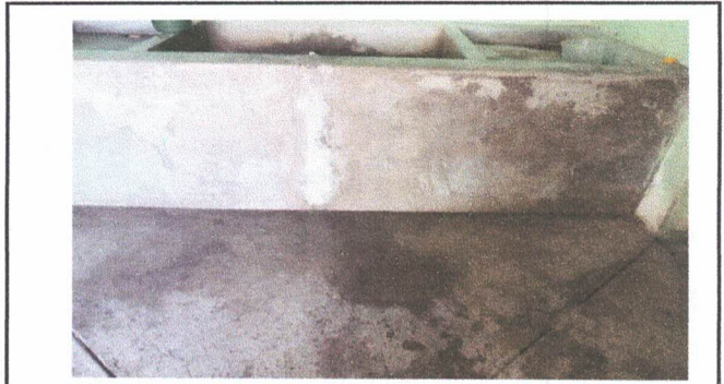
Foto 22: Sustitución de piso de torta de concreto por piso cerámico antideslizante
