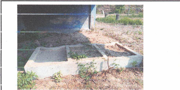
Foto 11: Sustitución de Pila de Cemento de un lavadero
