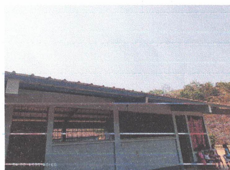
Foto 4: Sustitución de canal y bajada de agua pluvial
