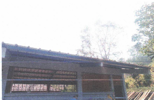
Foto 3: Mantenimiento a estructuras de metal de ventanas
