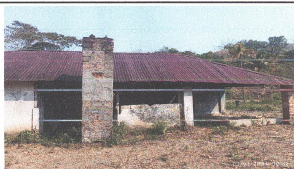
Foto 6: Aplicación de pintura a muros interiores y exteriores
