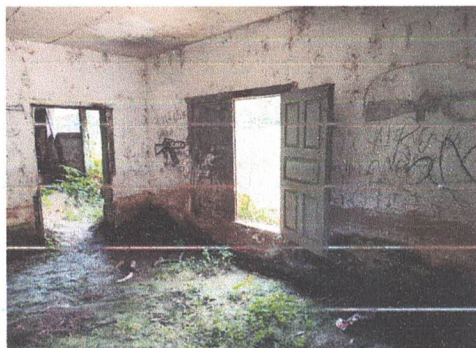
Foto 1: Sustitución de puertas
