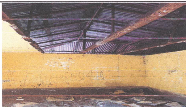
Foto 5: Aplicación de pintura a muros interiores y exteriores
