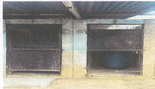
Foto 4: sustitucion de puertas en servicios sanitarios
