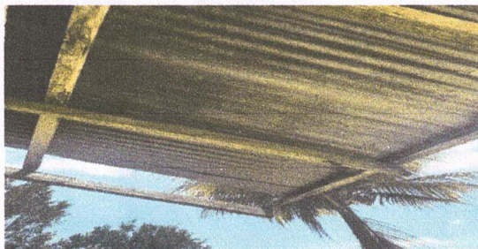
Foto 3: sustitucion de estructura de madera, por metal
