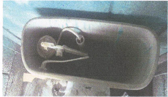
Foto 2: sustitucion de accesorios inodoro (contra llave, tubo de abasto)
