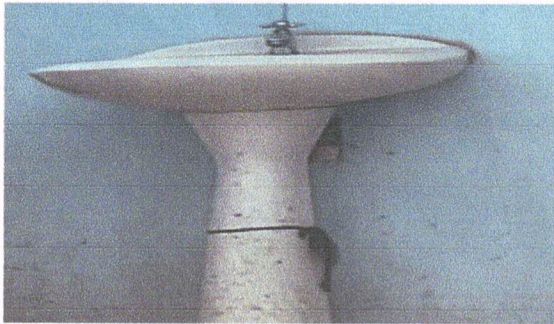
Foto 3: sustitucion de lavamanos
