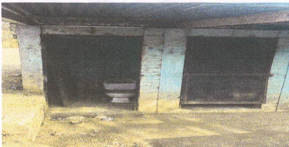
Foto 5: sustitucion de puertas en servicios sanitarios
