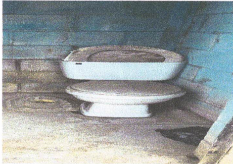
Foto 1: sustitucion de inodoros
