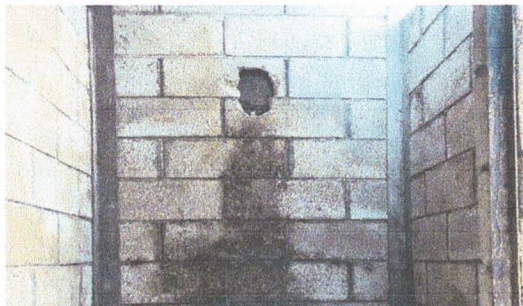
Foto 1: azulejos en muros de sanitarios
