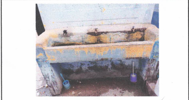
CAMBIO DE GRIFOS Y MANTENIMIENTO DE LAVAMANOS
