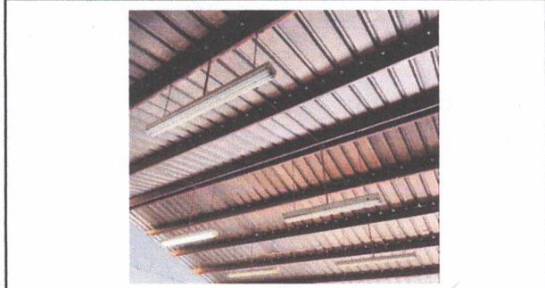
REPARACIÓN DE SISTEMA ELECTRICO
