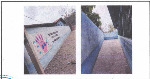
PINTURA EN MUROS EXTERIORES E INTERIORES
