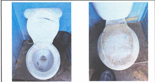
SUSTITUCIÓN DE INNODOROS
