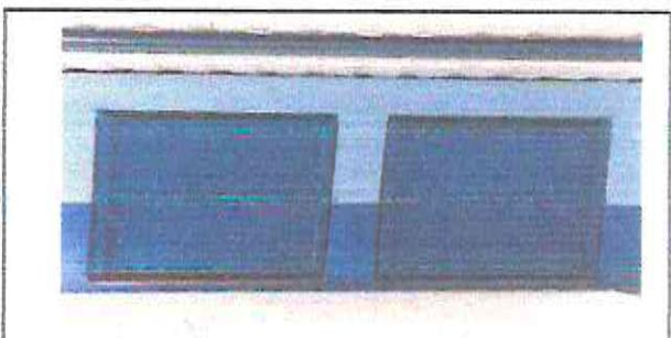
Reparación de puertas de metal de 0.90 de ancho por 2.15 mts de alto (incluye lijado, cepillado y pintura)
