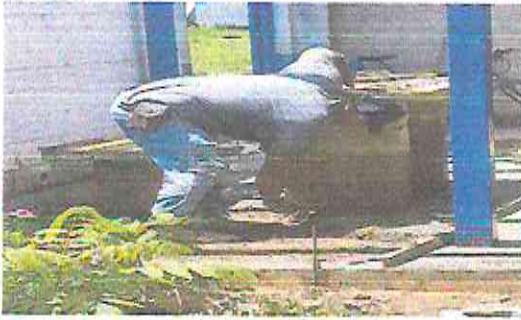
Sustitución de piso de torta de concreto
