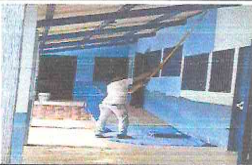
pintura de muro de interior y exterior
