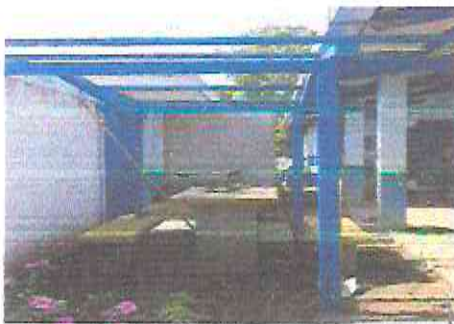
sustitución de estructura de soporte de madera por metal
