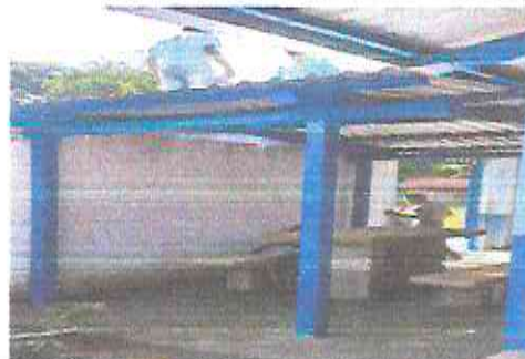
Sustitución de lámina por lámina troquelada aluzinc calibre 26
