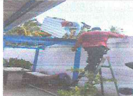
sustitución de lámina por lámina troquelada aluzinc calibre 26
