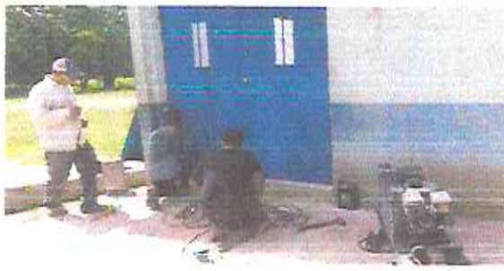
Mantenimiento a portones de metal
