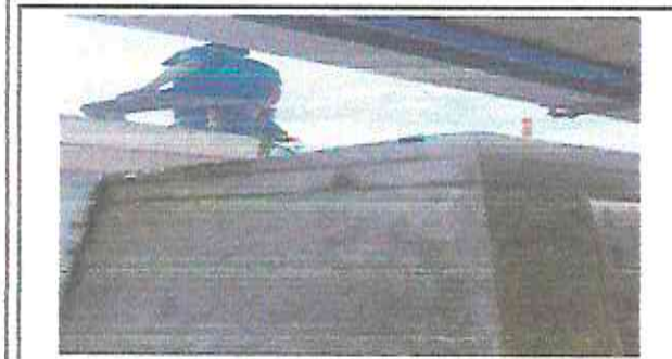
sustitución de lámina por lámina troquelada aluzinc calibre 26
