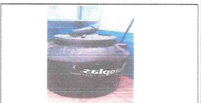
SUSTITUCION DE DEPOSITO DE AGUA ROTOPLAST, SE COLOCARÁ EN BASE DE CEMENTO AÉREA
