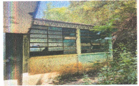
FOTO 1: Pintura de muros en Bodega.
