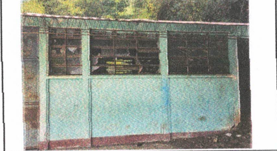
FOTO 8: Pintura y restauración de ventanal en bodega
