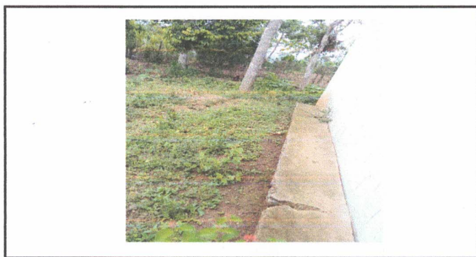
FABRICACIÓN DE CUNETA DE CONCRETO ✓
