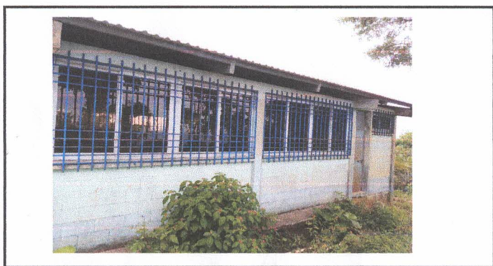
PINTURA EN MUROS INTERIORES Y EXTERIORES ✓
