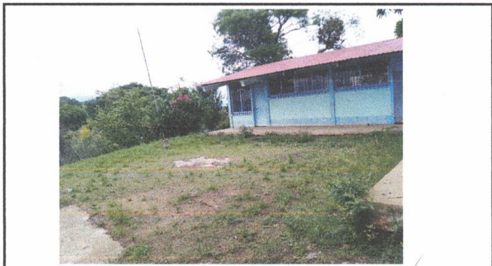
SUSTITUCIÓN DE TORTA DE CONCRETO
