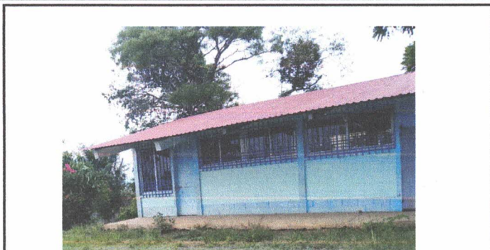
SUSTITUCIÓN DE LÁMINA TROQUELADA ALUZINC CALIBRE 26 ✓
