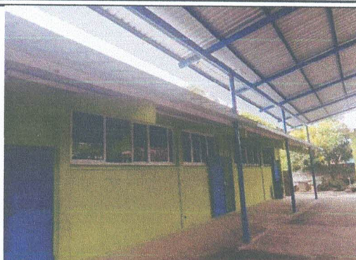
Foto 2: Instalación de canales
