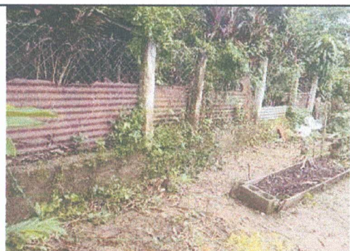
Foto 5: Reparación de muro perimetral
