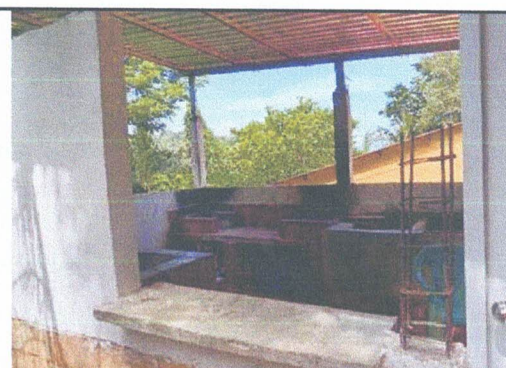
Foto 4: Instalación de ventana de metal
