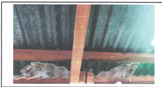
Foto 6: Sustitución de estructura de soporte de madera por metal
