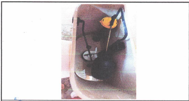
Foto 5: Sustitución de sanitarios con sus accesorios
