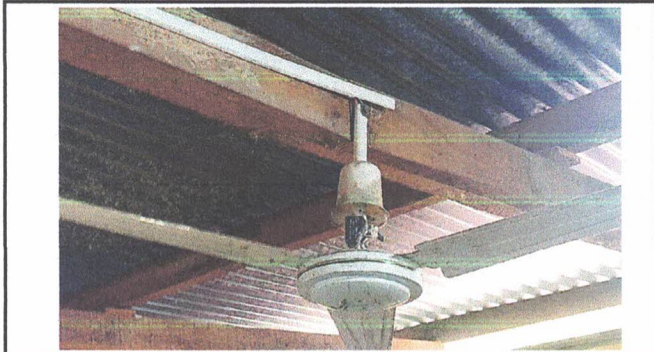
Foto 9: Sustrucción de lámina por lámina troquelada calibre 26
