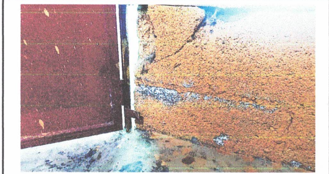
Foto1: Sustitución de muros de las paredes en las aulas estan dañadas en la parte de adentro
